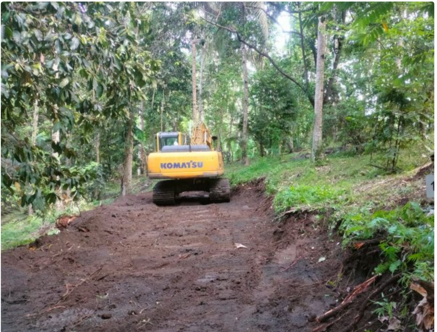
Pekerjaan Perintisan Jalan Pertanian pada TMMD Ke-116 Kodim 1310 Bitung di Tandurusa
