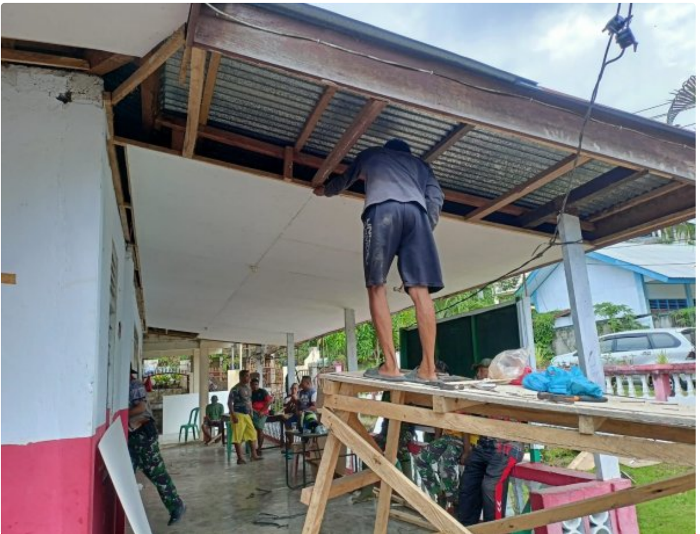
Satgas TMMD Renovasi Kantor Kelurahan Tandurusa
